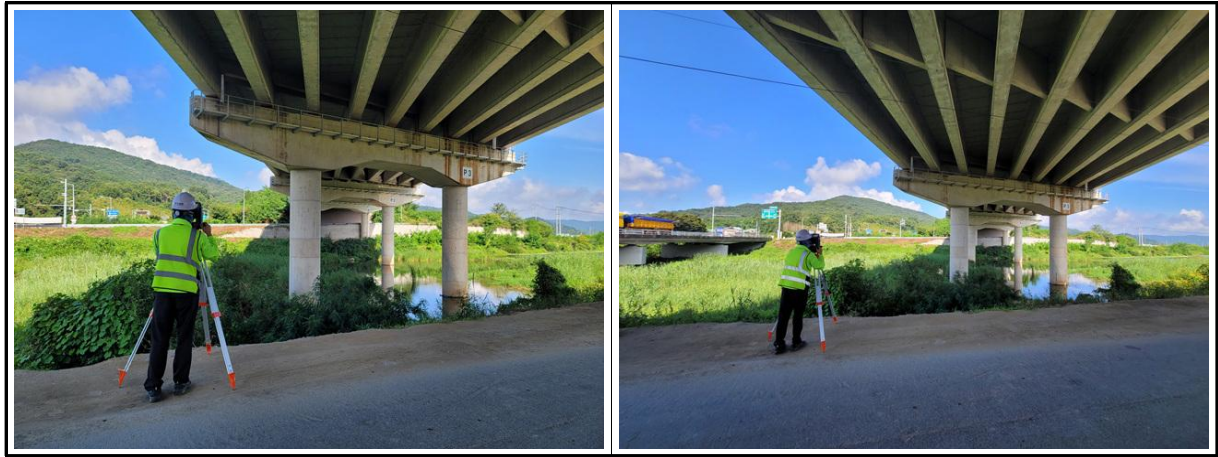
【사진 3.4.2】 측량작업 전경
