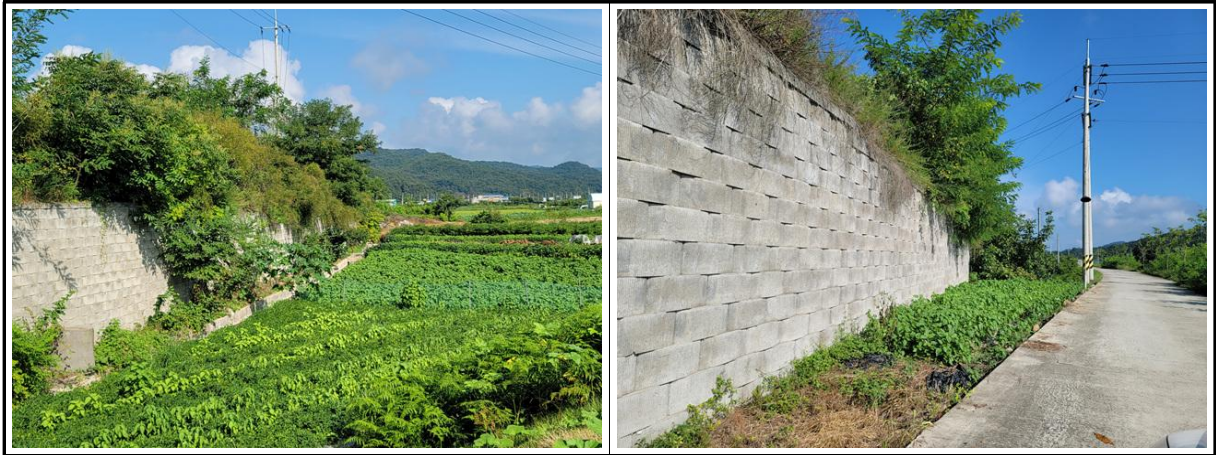
【사진 3.3.1】 지반, 기초부 전경
